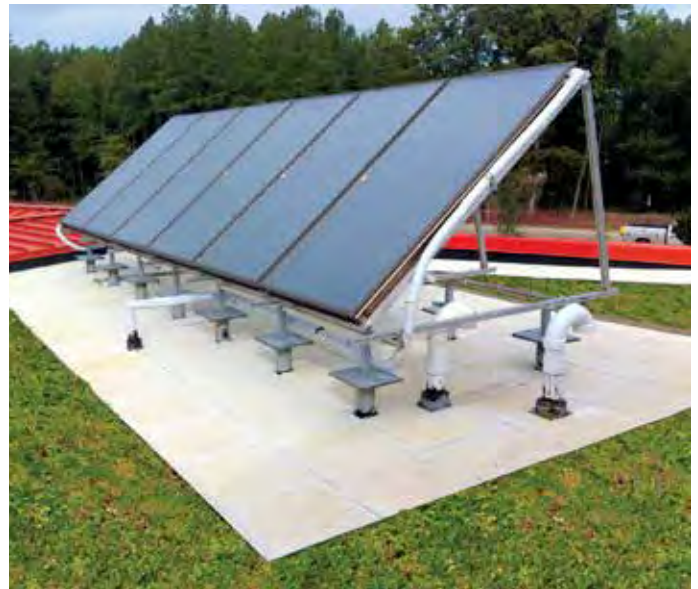
Fort Belvoir Dental Clinic - Fort Belvoir, VA
